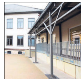
Behindertengerecht: Es gibt außen eine Rampe.
